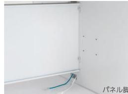
パネル脚内側およびセンター脚には、床からダクトに立ち上げる縦配線ダクトが設けられています。
